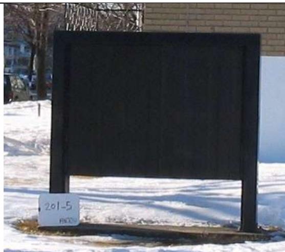
Armoire d'interconnexion de type BJI 3000 sur socle de béton
