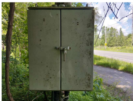
Armoire d'interconnexion de type BJI 3000 sur socle de béton
